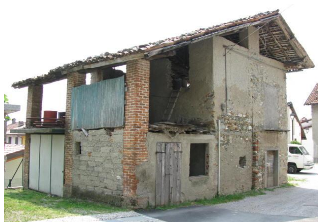
PROSPETTO SU CORTE INTERNA
